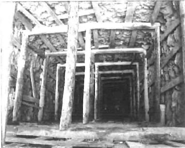
Resim 1A.11. Kuyu Geçici Ahşap Destek
