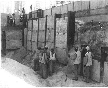
Resim 1A.3. Berlin Duvarı İmalatı
