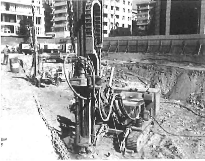
Resim 1A.15. Mini Kazık Makinesi
