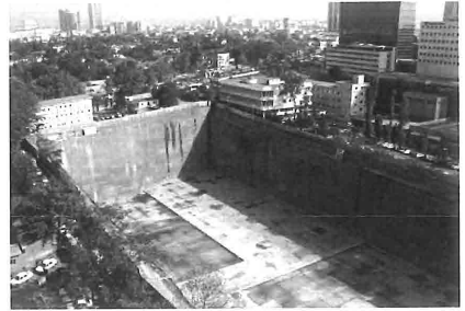
Resim 1A.14. Zemin Çivili Duvar
