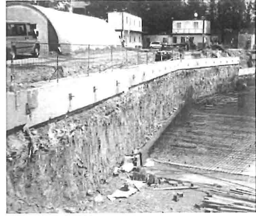
Resim. 1A.6. Jetgrout Elemanları ile Duvar
