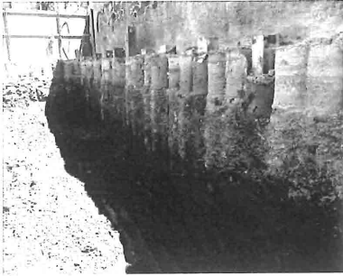
Resim. 1A.5. DSM Elemanları ile Duvar
