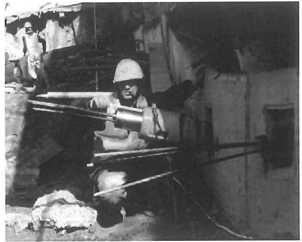
Resim 1A.10. Ankraj germe testi
